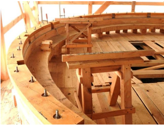
Auf diesem Lagerkranz dreht sich später die Kappe. Die Metall-Laufbahn für die Kugeln des Lagers ist hier noch nicht montiert.
