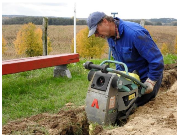
Beim Verdichten der Erdschicht über dem Kabel. Das Gerät wird verharmlosend „Hopser“ genannt, aber es erfordert doch einige Kraft, um es in der Spur zu halten.
