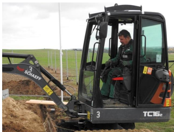
Mit einem Kleinbagger wurden die Kabelgräben gezogen.
