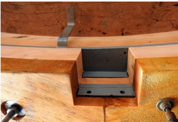
Der äußere Kranz wird auch die Seitenführungsrollen aufnehmen.
