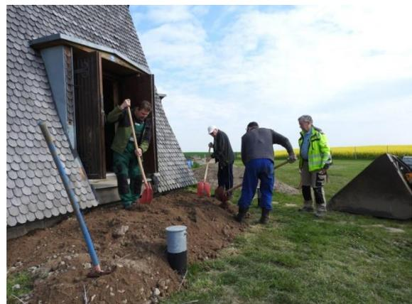
Da der Mühleneingang umgebaut werden muss, wurde es notwendig, das Gelände vor der Mühle aufzuschütten. Bernd Strack holte mit einem großen Teleskoplader Recycling-Material vom Parkplatz, Christian Koch verdichtete es mit einer Rüttelplatte. Danach wurde Muttererde aufgefüllt und mit der Schippe verteilt. Das übernahmen Reinhard Roland, Ingo Waligora, Hartmut Hinze, Wolfgang Machai und Jörg Berkner. Ein alter Mühlenstein bildet nun die erste Treppenstufe zum Mühleneingang.
