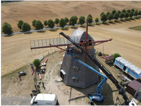
Flügel Nr. 1 wird montiert.
